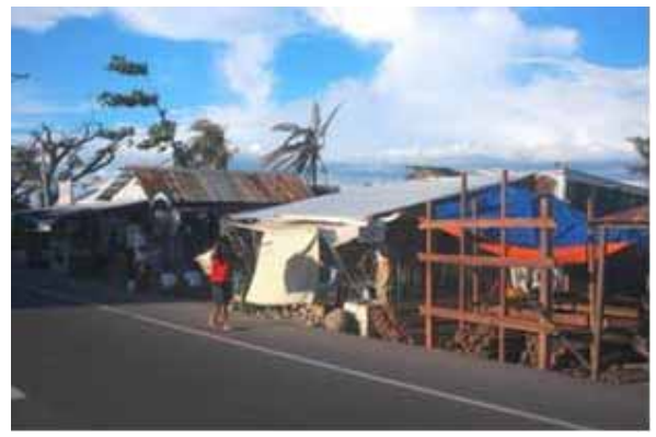
再建中の住宅
