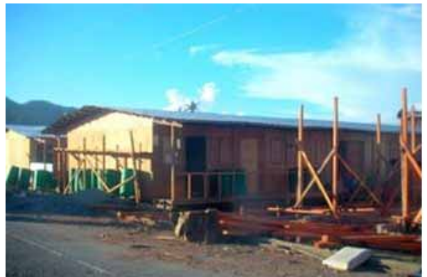
建設中の仮設住宅
