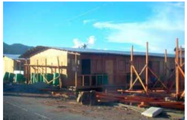
建設中の仮設住宅
