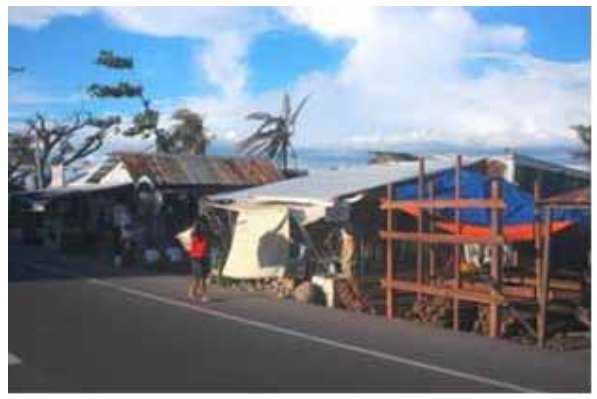
再建中の住宅
