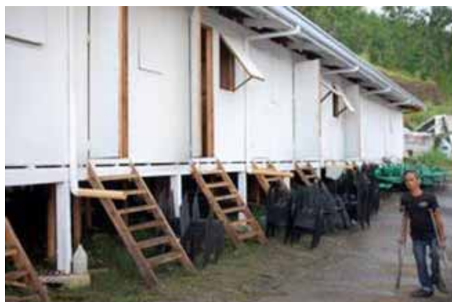
事務所の隣に設置された仮設住宅
